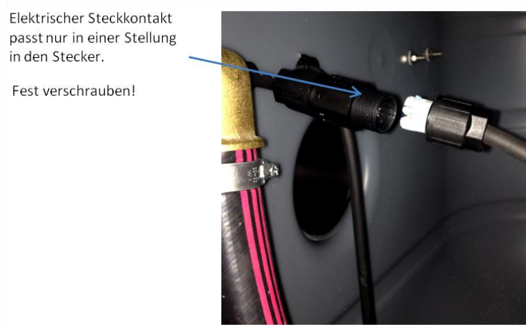
Abbildung 6: elektrischer Steckkontakt der Tauchdruckpumpe anschließen
