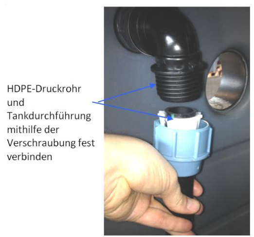
Abbildung 5: Druckanschluss zwischen Tauchdruckpumpe und Tankdurchführung herstellen
