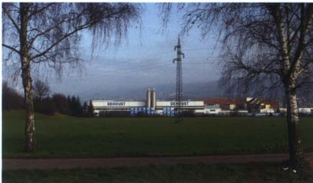
Dehoust-Werk in Leimen
