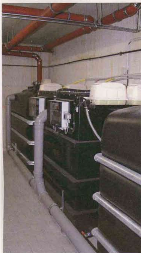
Diese Maschine der GEP Umwelttechnik GmbH recycelt das Grauwasser aus 90 Mannheimer Studentenwohnungen. Firmenfoto
