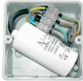
Bild 7: Verteilerdose mit angeklebtem Kondensator
